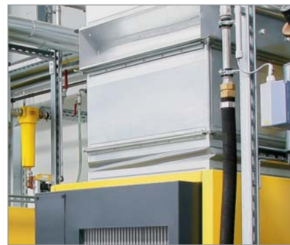
Fig. 2 : Raccordement du gainage par un manchon en toile
